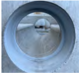
PROFILOVÝ VSTUP DLE TYPU POTRUBÍ
