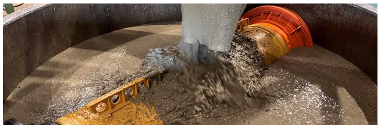
Ukládání SCC betonu do formy TIBA CORPROTECT®
